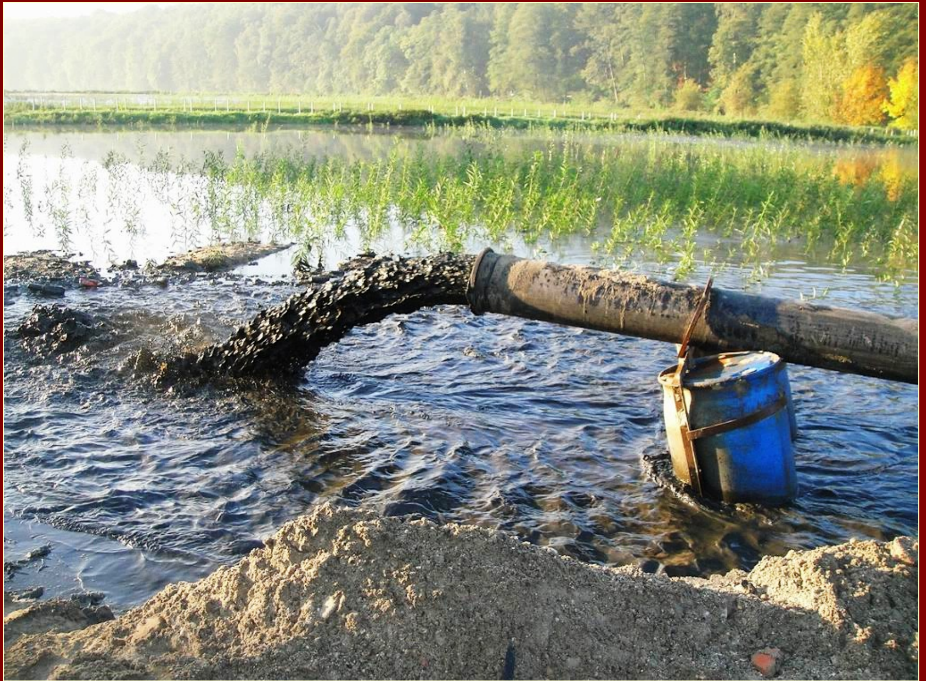
Schlamm wird in ein Spülfeld gepumpt
