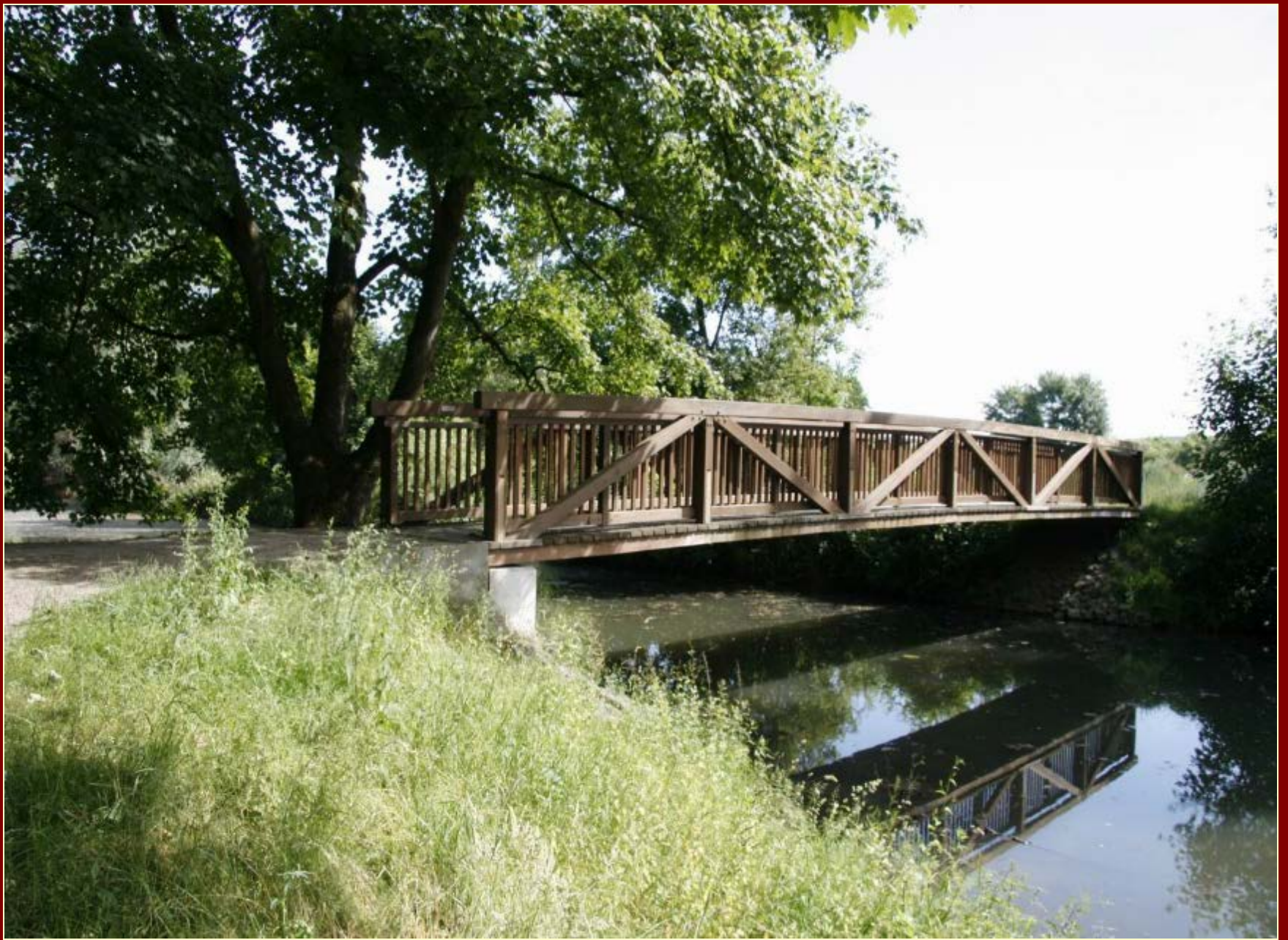
Die neue Luisenbrücke über dem Kermisdahl - 2006
